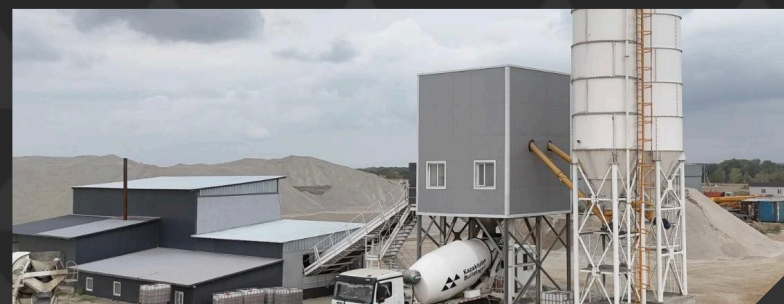
БЕТОННЫЙ ЗАВОД НА ПЛОЩАДКЕ КАРЬЕРА
