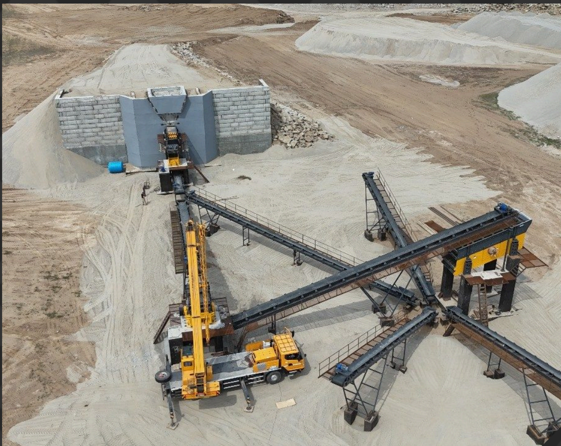
ДРОБИЛЬНО-СОРТИРОВОЧНЫЙ КОМПЛЕКС НА ПЛОЩАДКЕ КАРЬЕРА
