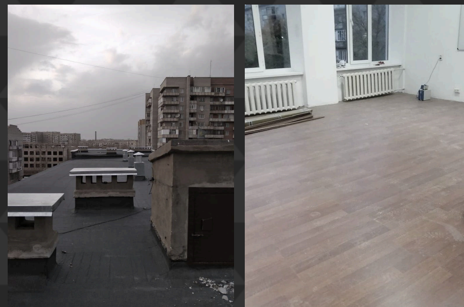
ХОД РАБОТ: СЛУЖБА ПО ПРОТИВОДЕЙСТВИЮ КОРРУПЦИИ, Г. СЕМЕЙ — ФАСАД, КРОВЛЯ, ВНУТРЕННЯЯ ОТДЕЛКА
