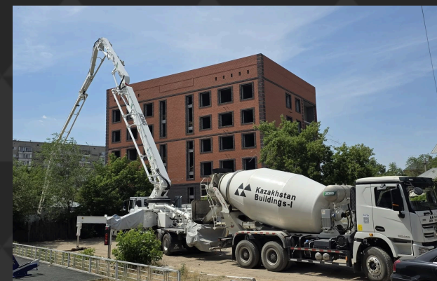
ПОДАЧА БЕТОНА АВТОБЕТОНОНАСОСОМ НА ОБЪЕКТЕ
