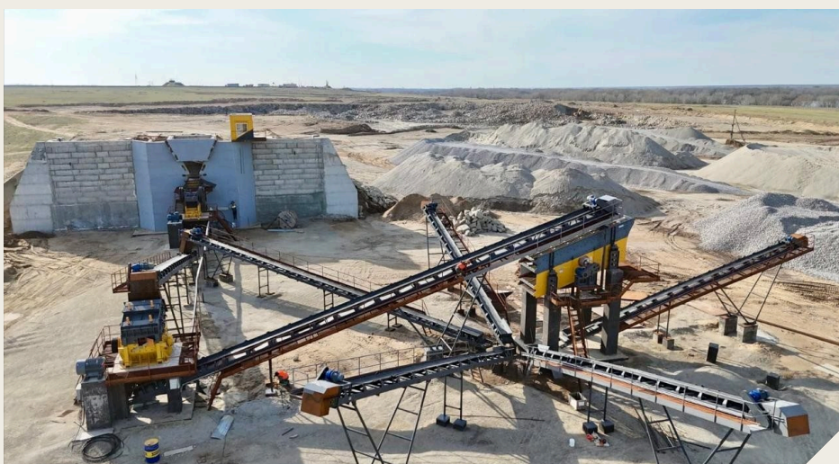
ОБЩИЙ ВИД ПЛОЩАДКИ: ДРОБИЛЬНЫЙ КОМПЛЕКС И ШТАБЕЛИ ФРАКЦИЙ
